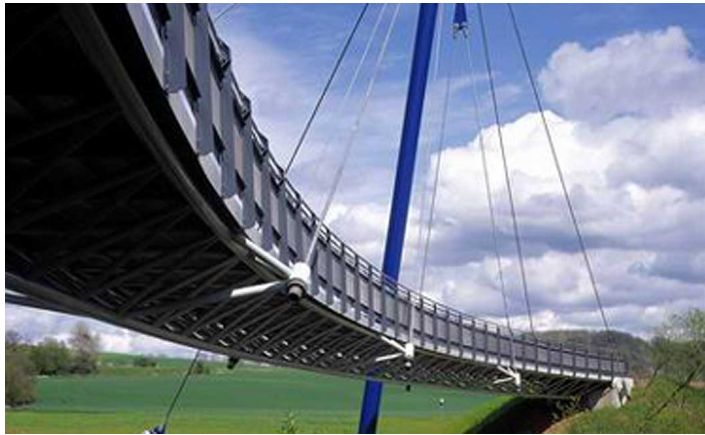
Pylon und Überbau
