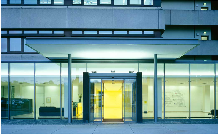
Eingang mit Vordach
