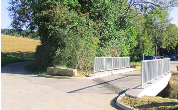
Brücke über den Rohrbach
