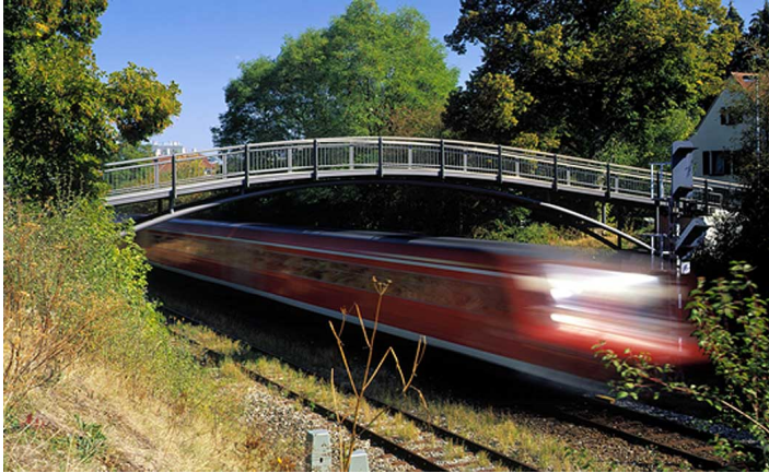
Fußgängersteg bei der Filserstraße | Balingen
